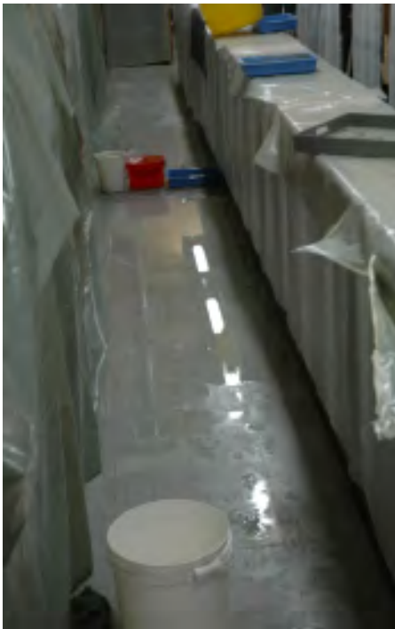
Figure 2. La collection inondée et bâchée pour la protéger (2008).
